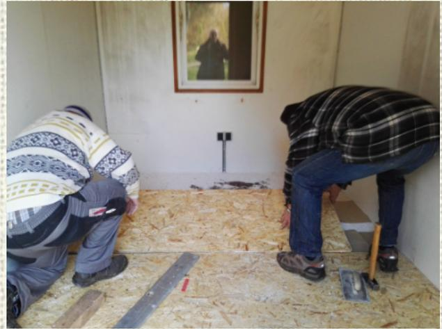
Ausgleichsmaterial füllt Unebenheiten unter dem neuen Boden aus.
