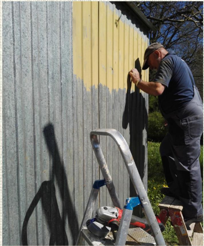
Der alte Lack auf dem verzinkten Blech wurde auf Dach und Seitenteilen abgeschliffen und eine neue Grundierung aufgetragen.
