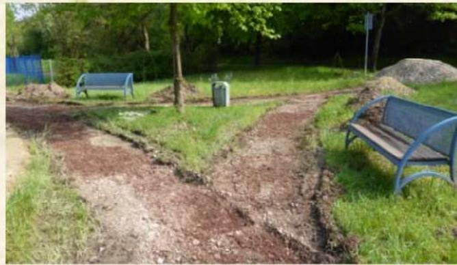
Mithilfe eines Baggers wurde die Vorarbeit zur Sanierung der Wege geleistet. Nach Einbringen eines Vlieses konnte der Splitt aufgeschüttet werden, es waren viele Fahrten mit der Schubkarre notwendig.
